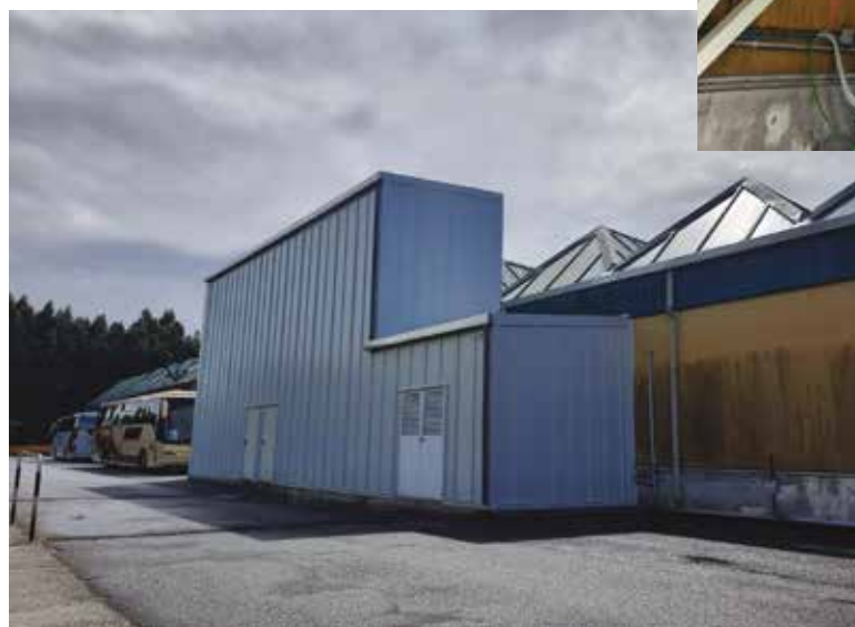
Nuevos silos de harina en las instalaciones de Hornos de Lamastelle
